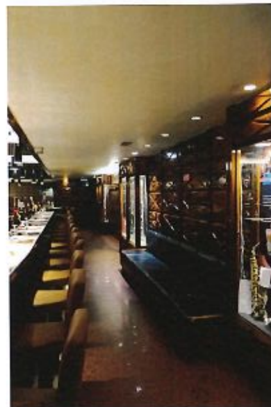
Fig. 63. Vista do interior do snack-bar Galeto (PM 2023), onde é possível observar o pavimento em laje de pedra, colocado em substituição da alcatifa, em face das novas normas de utilização e higiene.
