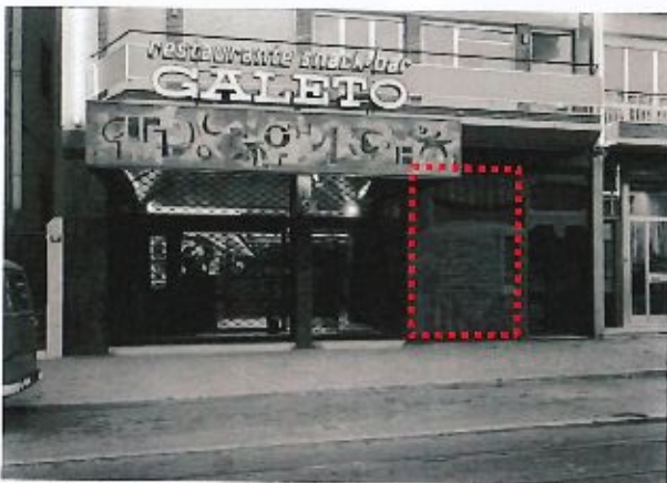
Fig. 56. Nesta imagem observa-se a presença da parede de betão demolida (c. 1966).
