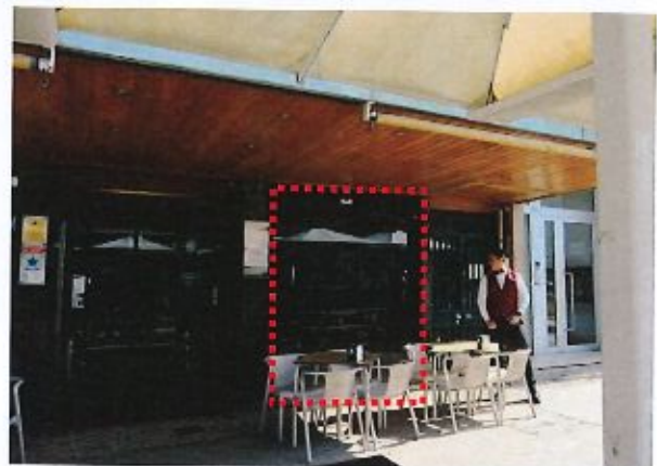
Fig. 57. Imagem da fachada, atualmente com a janela de vidro, PM 07.02.2023.
