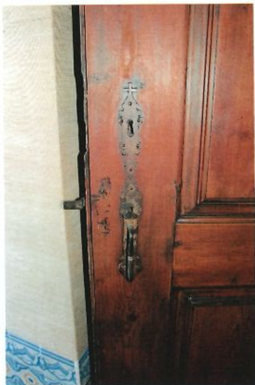
Fig. 54 - 2º piso. Porta interior - fevereiro de 2024
