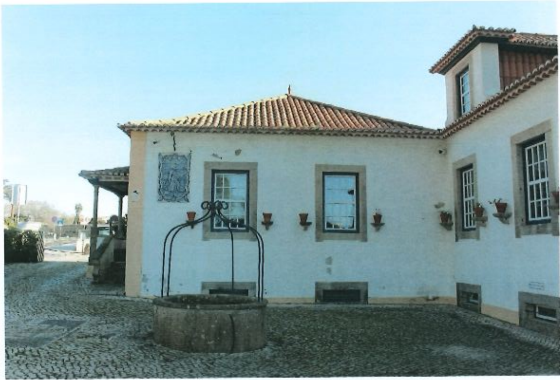
Fig. 34 - Casa de S. Bernardo. Fachada Sudoeste e poço com roldana. Fevereiro de 2024
