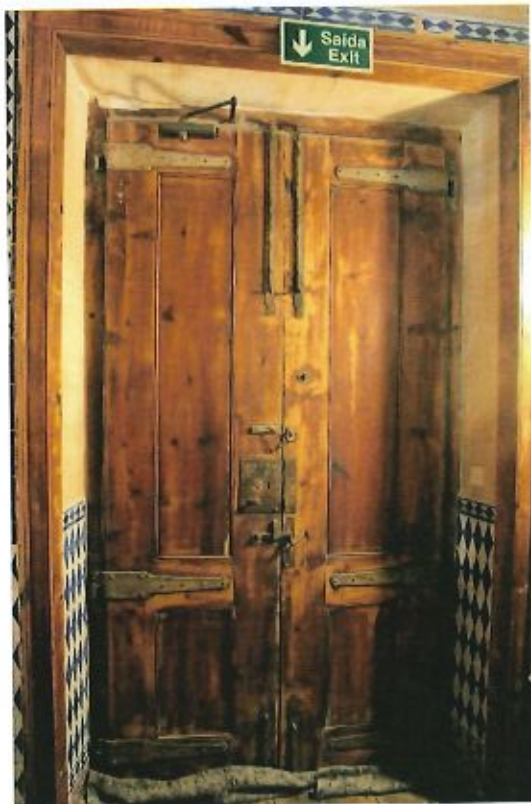
Fig. 61 - 2º piso - Porta de saída. Fevereiro de 2024
