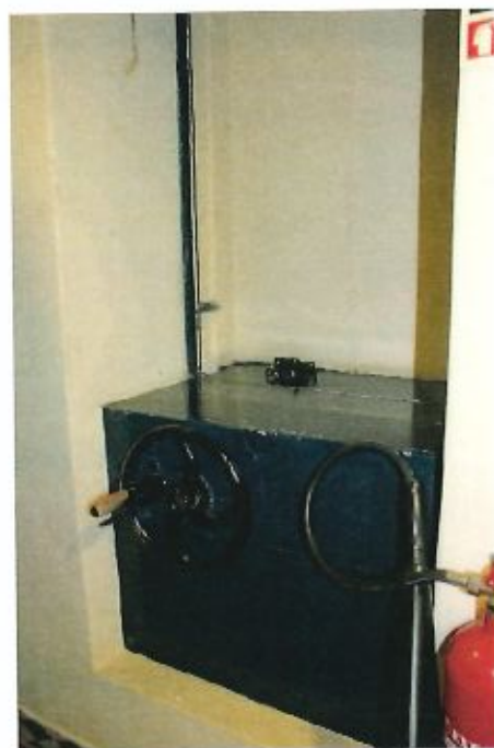
Fig. 66 - 1º piso - Caixa do elevador das refeições. Fevereiro de 2024
