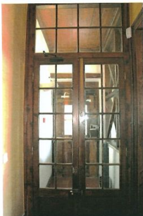
Fig. 52 - 2º piso. Porta do vestíbulo de entrada
