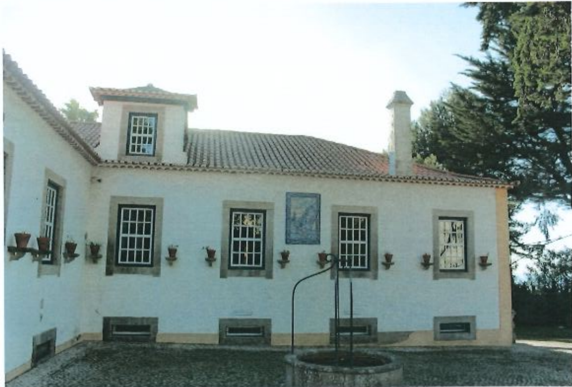
Fig. 35 - Casa de S. Bernardo, fachada Noroeste. Fevereiro de 2024
