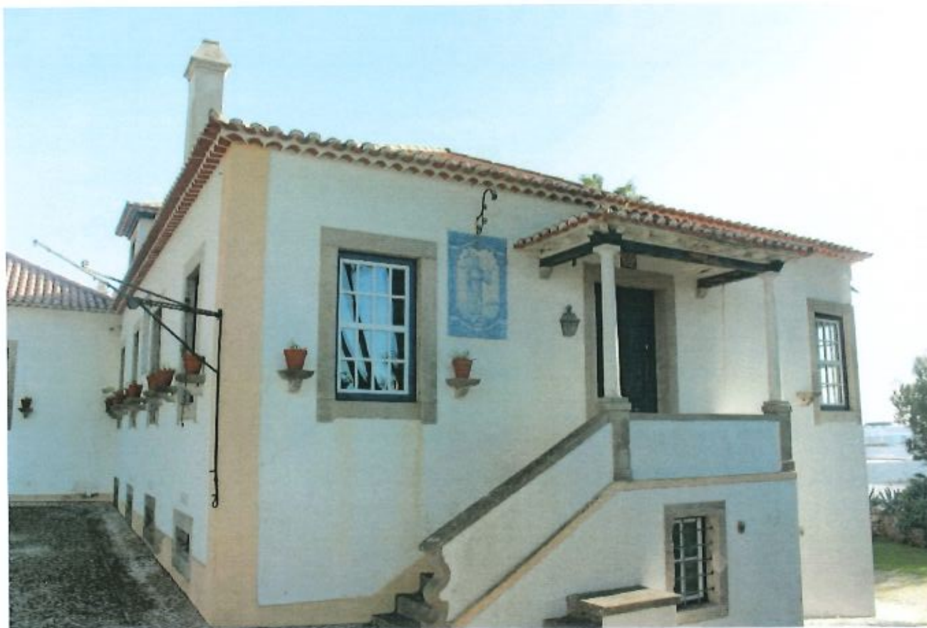
Fig. 40 - Fachada Sudoeste. Fevereiro de 2024
