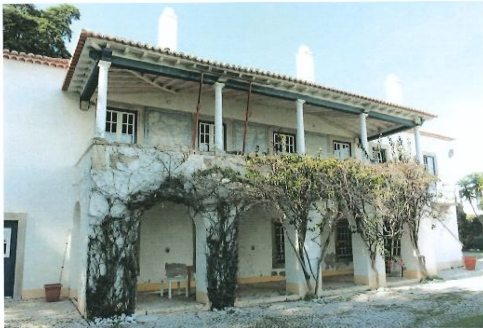
Fig. 2 - Fachada Sudoeste - março de 2023
