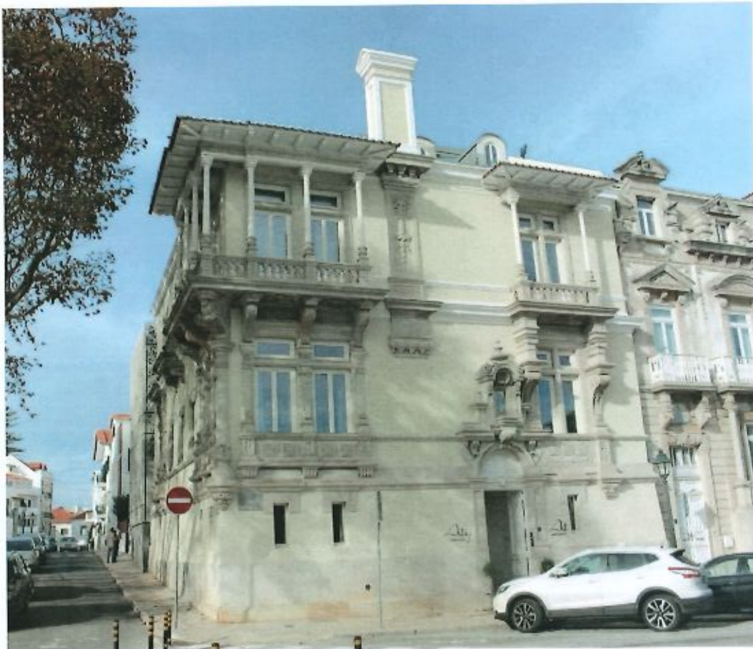
Fig. 12 - Casa Trindade Baptista (1899). Avenida D. Carlos I
