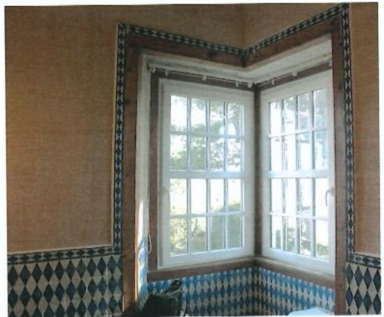
Fig. 62- 2º Piso - Gabinete com duas janelas de canto. Fevereiro de 2024
