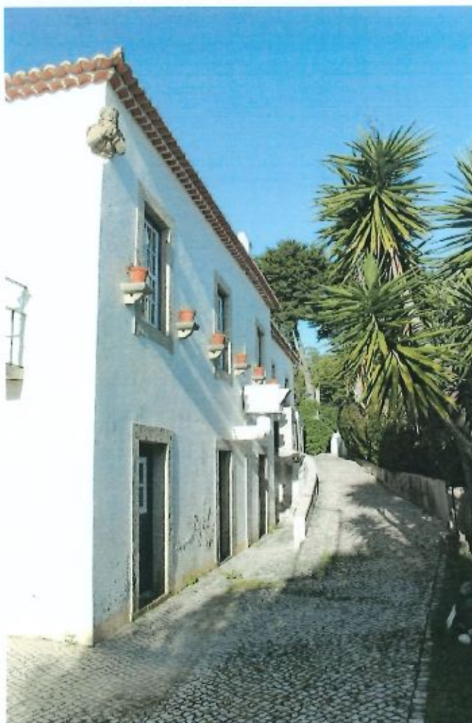
Fig. 46 - Fachada Nordeste. Fevereiro de 2024
