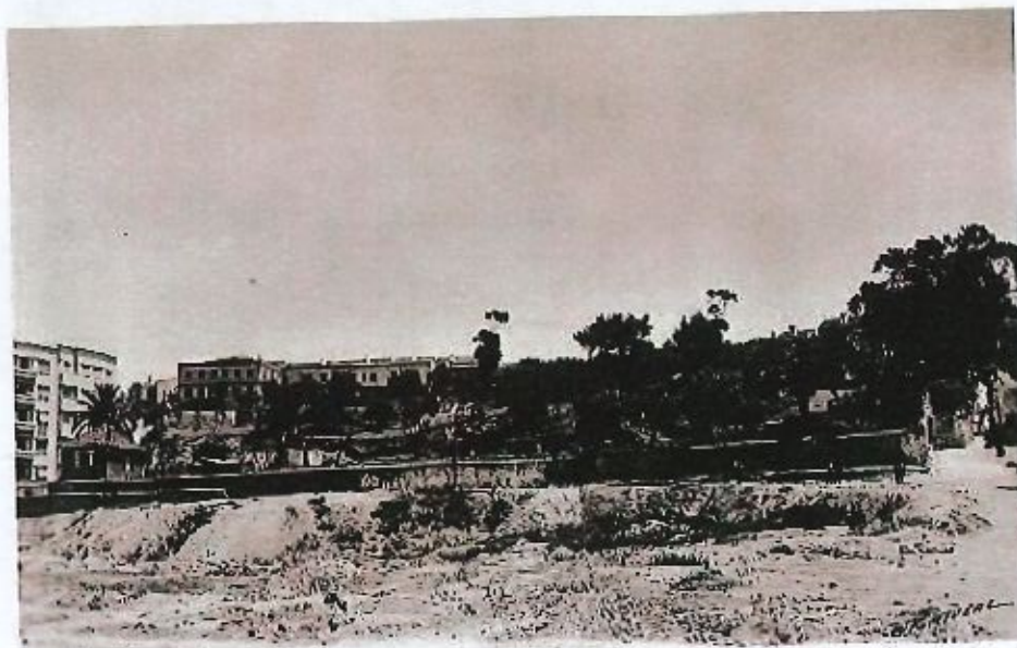
Fig. 7 - Antiga Azinhaga do Arelro em 1939, vendo-se a Quinta do Alporche e, à esquerda, a Calçada da Ladeira, que dava acesso à sua entrada principal. Eduardo Portugal, Arquivo CML.
