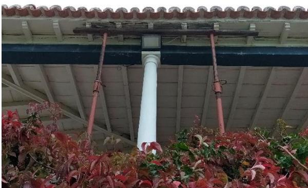
Fig. 35. Beiral da varanda em risco de colapso (PM, 15.10.2024).
