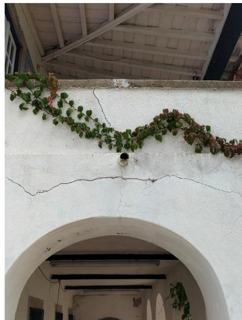
Fig. 40. Presença de fissuras na estrutura de arcos portantes da varanda (PM, 15.10.2024).
