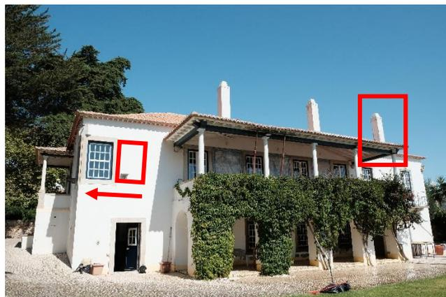
Fig. 6. Fachada sudeste. PM, 05.08.2024. Alterações da fachada sudeste, uma terceira chaminé na cobertura, e o reposicionamento da janela da fachada sul, para junto do cunhal (ver Fig. 4).
