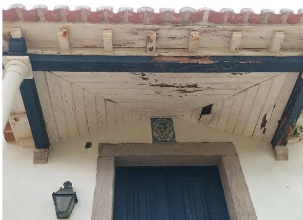
Fig. 39. Cobertura de madeira do alpendre, revestida a telha, de três águas (PM, 15.10.2024)
