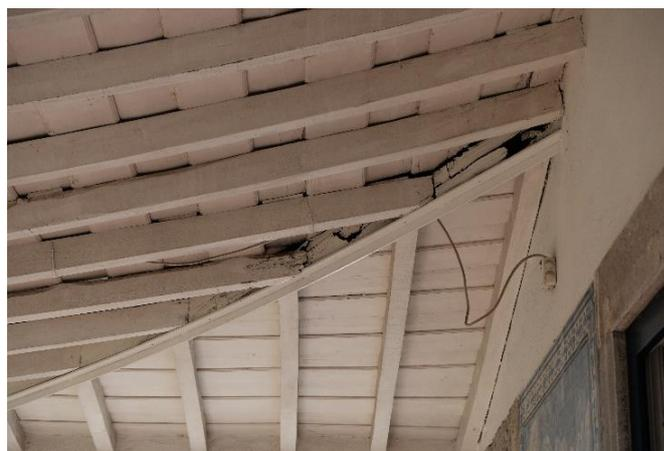
Fig. 36. Madeiras apodrecidas da estrutura de suporte da cobertura da varanda (PM, 15.10.2024).
