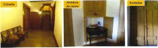
Alinhamento portas salas interiores
