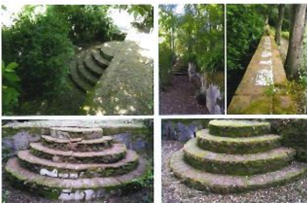
Escadas, muros e bancos
