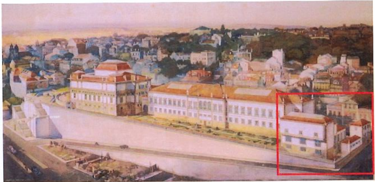
Fig. 10 - Vista perspetiva, tirada do Sudeste, do edifício que, de 1937 a 1939, se construiu para ampliar o Museu das Janelas Verdes, de Lisboa, sendo o programa do Dr. José de Figueiredo, antigo Director do mesmo Museu, e os projectos do Arquitecto Guilherme Rebelo de Andrade, Jaime Martins Barata, 1938, aguarela e gouache, 140 cm x 70 cm (1904131 TC, MNAA). A nascente, as novas oficinas e anexos.
