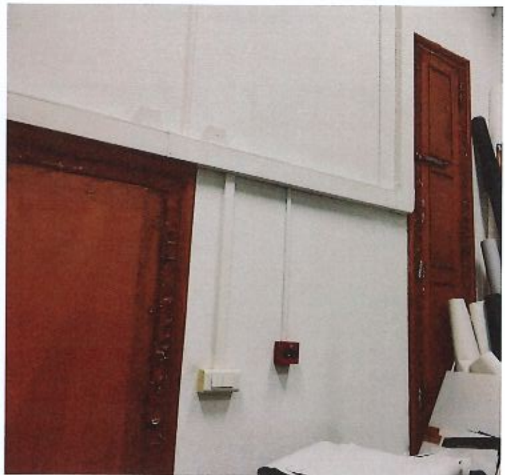
Fig. 26 - Revestimento de chumbo em torno dos vãos da sala de RX (as portas são duplas, com escudo de radiação interior).
