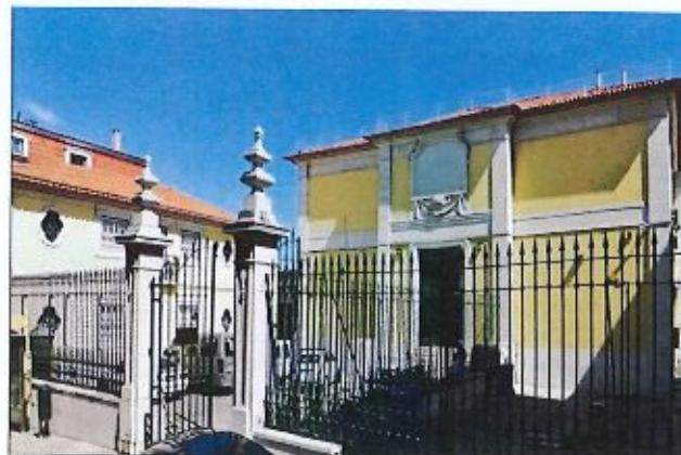
Fig. 13 - Fachada na atualidade (com alterações nos dois corpos laterais e na cobertura efetuadas em 1968).
