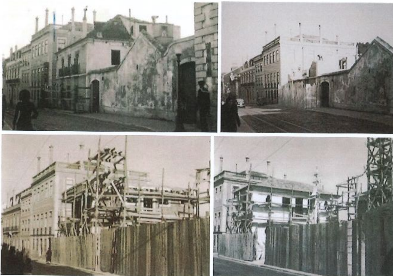
Fig. 8 – Em cima: casa dos irmãos Brederode, em preparação para ser demolida (4.2.2, nº 115, gov. 12, AFMNA), e demolição da mesma casa (SIPA FOTO.00133582). Em baixo: fases de construção da habitação do chefe do pessoal menor (AFMNA). Cfr. Henrique MARTINS, 2014, vol. II, p. 11.
