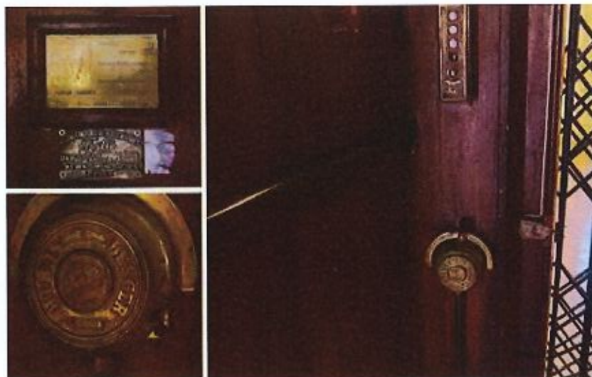
Fig. 23 – Detalhes do monta-cargas (Fotos LJF).
