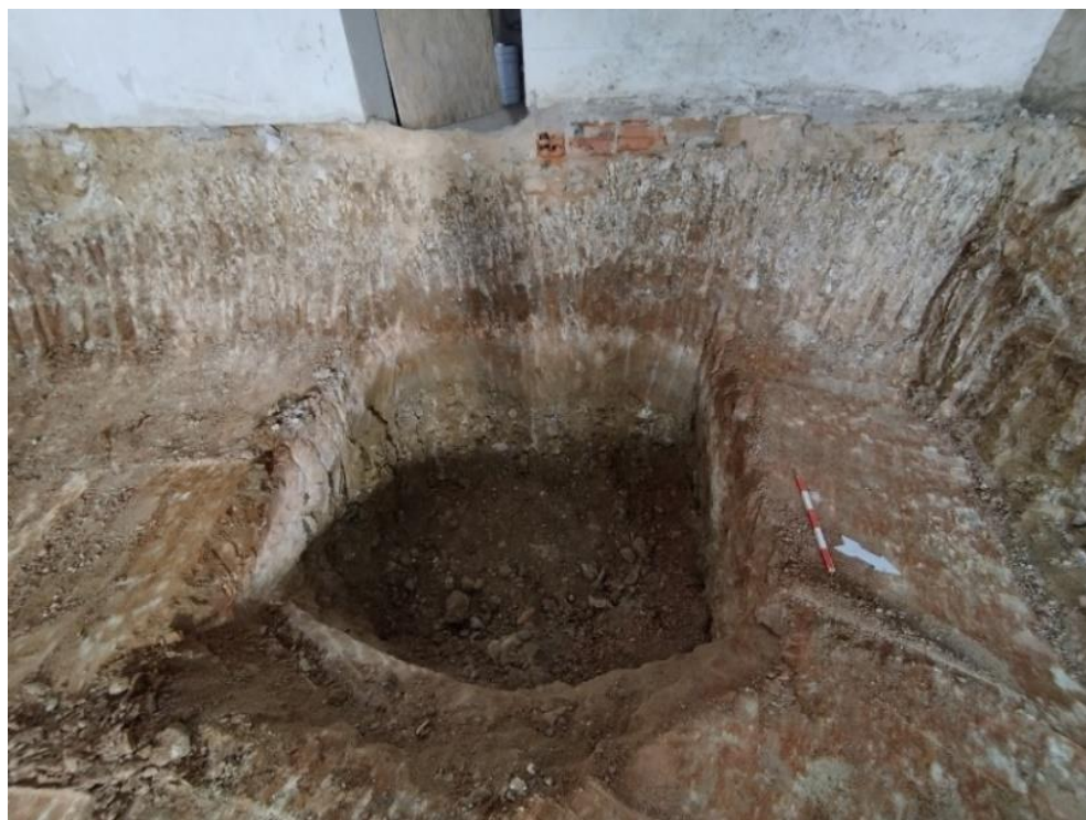
Foto 8_Plano final da zona do poço do elevador.
