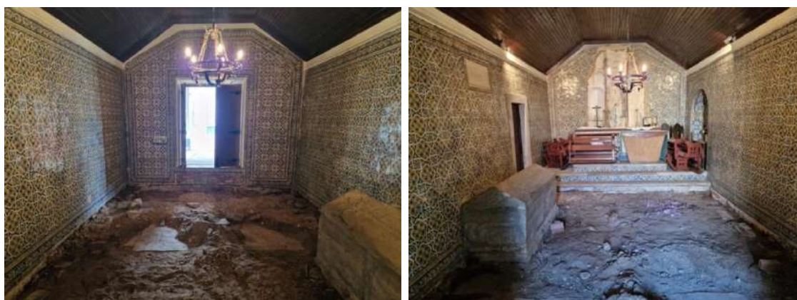
Foto 1 _Vista geral de este para oeste, no interior da capela.
