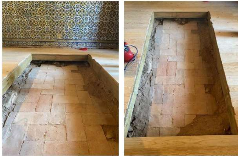
Fig. 3 e 4_Conclusão do novo pavimento em soalho de madeira.
