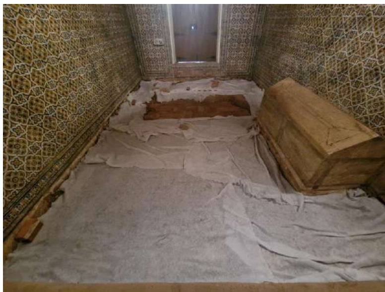
Foto 18_Aspeto final após colocação da manta geotêxtil em toda a área intervencionada.
