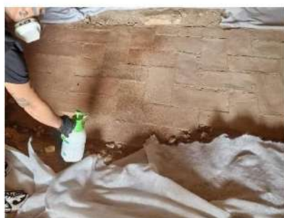
Fig. 9 e 10_ Aplicação de biocida preventivo.
