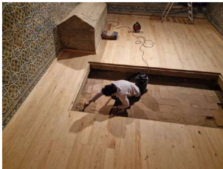
Foto 21_Aspetto de trabalhos de conservação e restauro finais.
