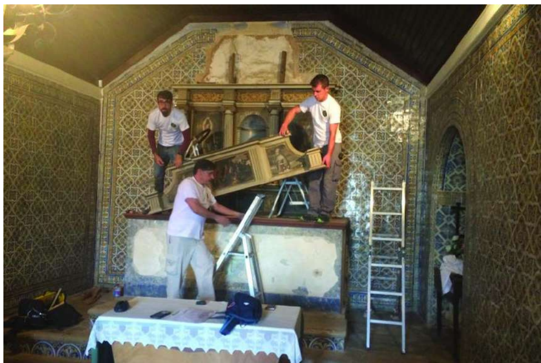
Figura 10_Aspeto dos trabalhos de remoção do retábulo da Capela de São Brás [Município do Bombarral, 2017].
