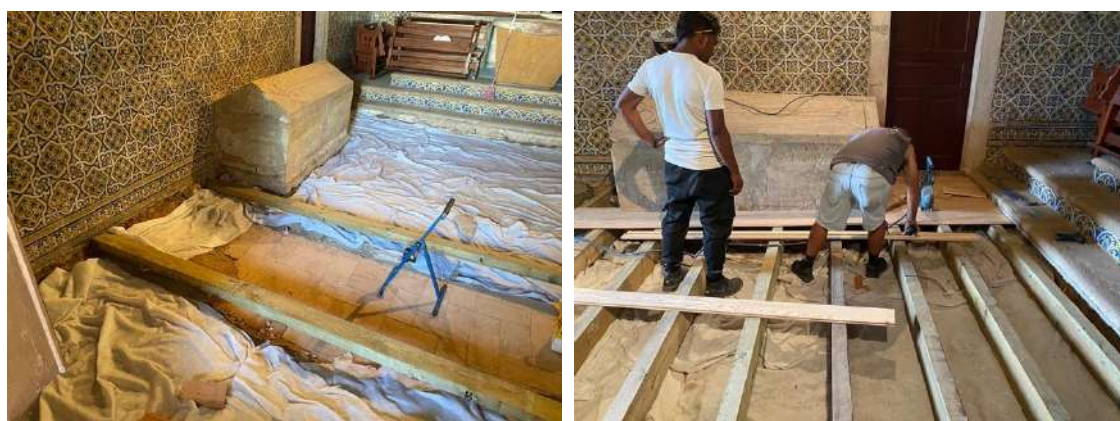
Fotos 19 e 20_Aspeto de trabalhos de aplicação de novo soalho de circulação.
