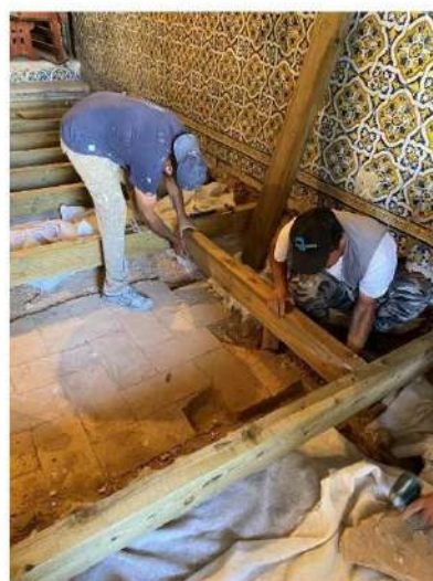
Fig. 1 e 2_Construção do novo pavimento em soalho de madeira.
