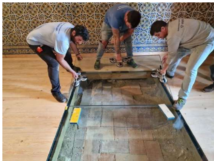
Fotos 22 e 23_Aspetto de trabalhos de aplicação dos painéis de vidro.
