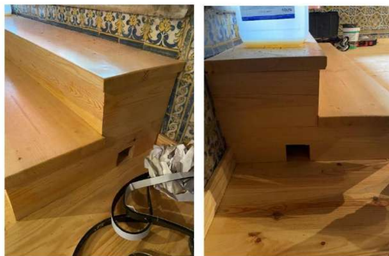
Fig. 5 e 6_Respiradouros nos degraus de acesso.
