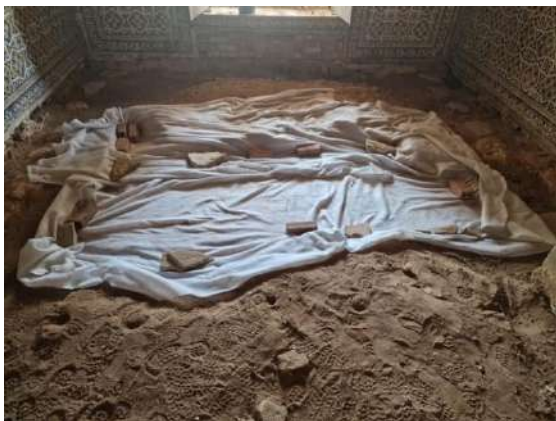
Foto 14_Aspeto da aplicação da manta geotêxtil.
