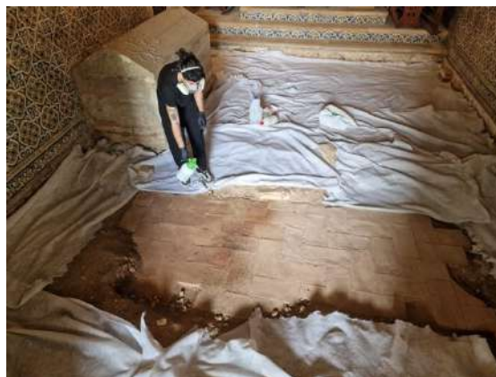
Foto 16_Aspeto da remoção do sedimento crivado e manta geotêxtil previamente colocados.
